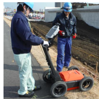
ハンディタイプレーダーによる埋設管確認状況
